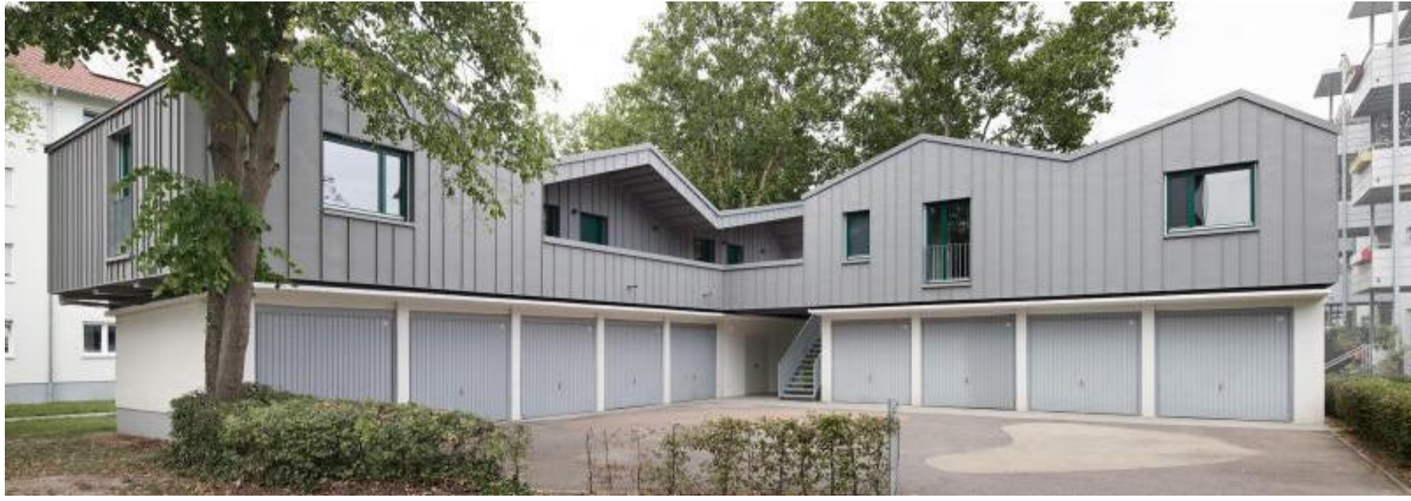
Die Volkswohnung in Karlsruhe hat modular, kreislauffähig und in Holzbauweise drei Garagenhöfe aufgestockt und so zwölf kompakte, öffentlich geförderte Wohneinheiten geschaffen. FOTO: STEPHAN BAUMANN
