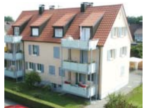
Neue Balkone und Vollwärmeschutz für Bestandswohnungen
