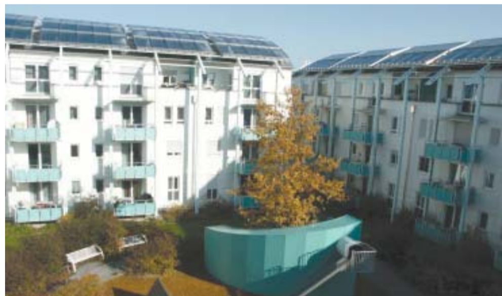
4.300 Quadratmeter Kollektorenfläche sparen in Wiggenhausen-Süd 40 Prozent an fossiler Energie
