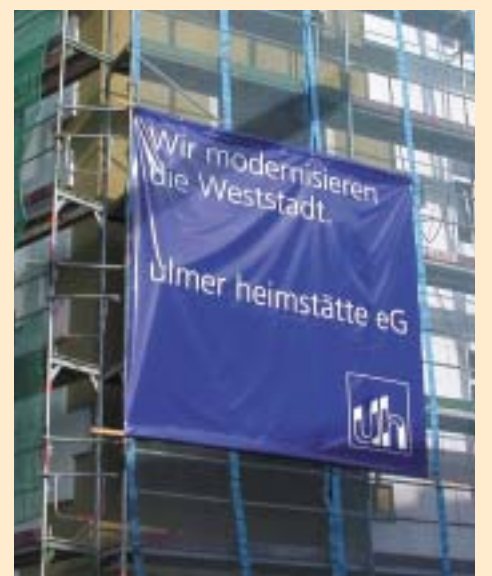
Modernisierung der ehemaligen Geschäftsstelle
