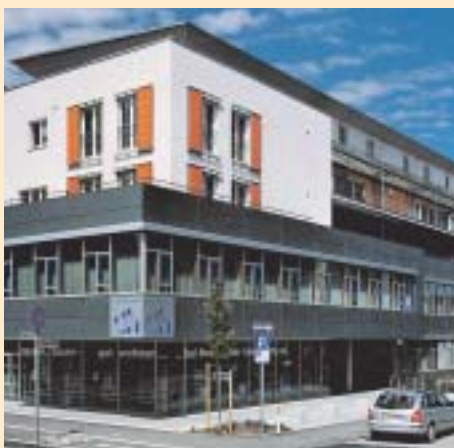
Im vergangenen Jahr bezog die ulmer heimstätte die neue Geschäftsstelle in der Weststadt. Das Gebäude gewährt Raum für die Büros des Unternehmens sowie für 17 Mietwohnungen.
