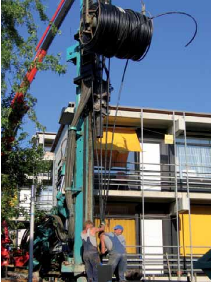
Mit schwerem Bohrgerät rücken Fachleute dem Untergrund zu Leibe, um die Erdwärme nutzbar machen zu können
