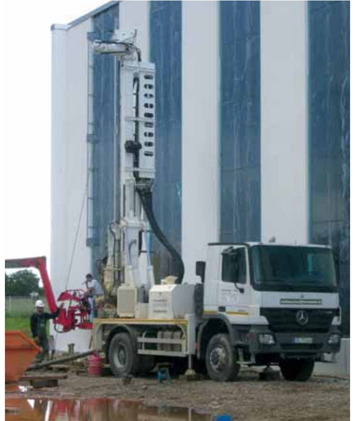
Mit schwerem Bohrgerät rücken Fachleute dem Untergrund zu Leibe, um die Erdwärme nutzbar machen zu können
