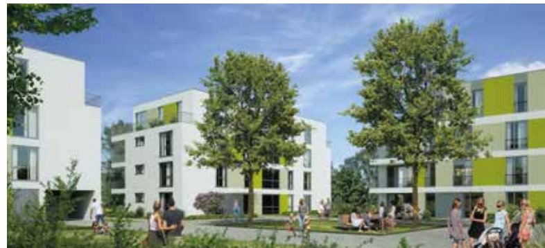
Für das Quartiersprojekt Luise-Bronner-Straße hat die Stadtsiedlung Heilbronn den Contracting-Preis BW 2020 erhalten
