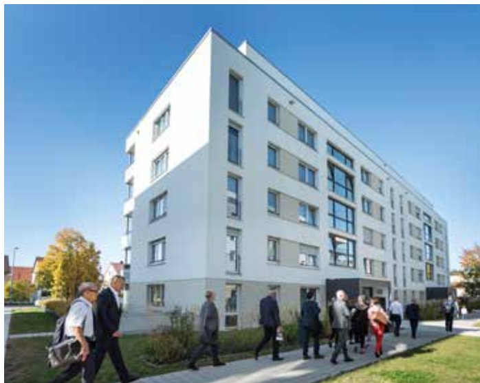
Eine Delegation der Wohnraum-Allianz Baden-Württemberg besuchte Neubaugenossenschaft Neues Heim eG im Stuttgarter Stadtteil Giebel.
