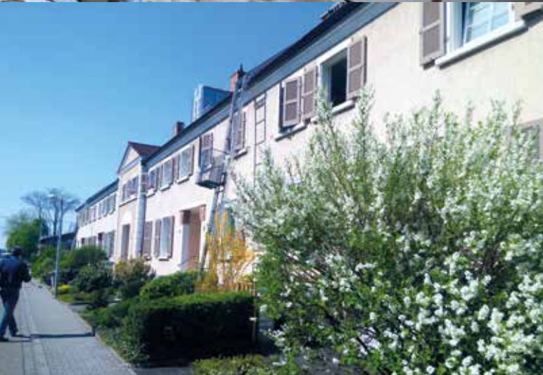
Denkmalschutz und Sanierung im Einklang bei der Gartenstadt-Genossenschaft in Mannheim
