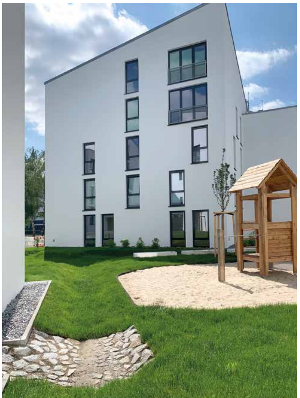
Offene Gemeinschafts- und Freiräume im Quartier bieten Raum für Begegnung
