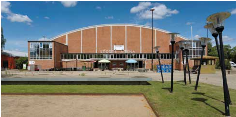
Die denkmalgeschützte Sportsarena auf Franklin
