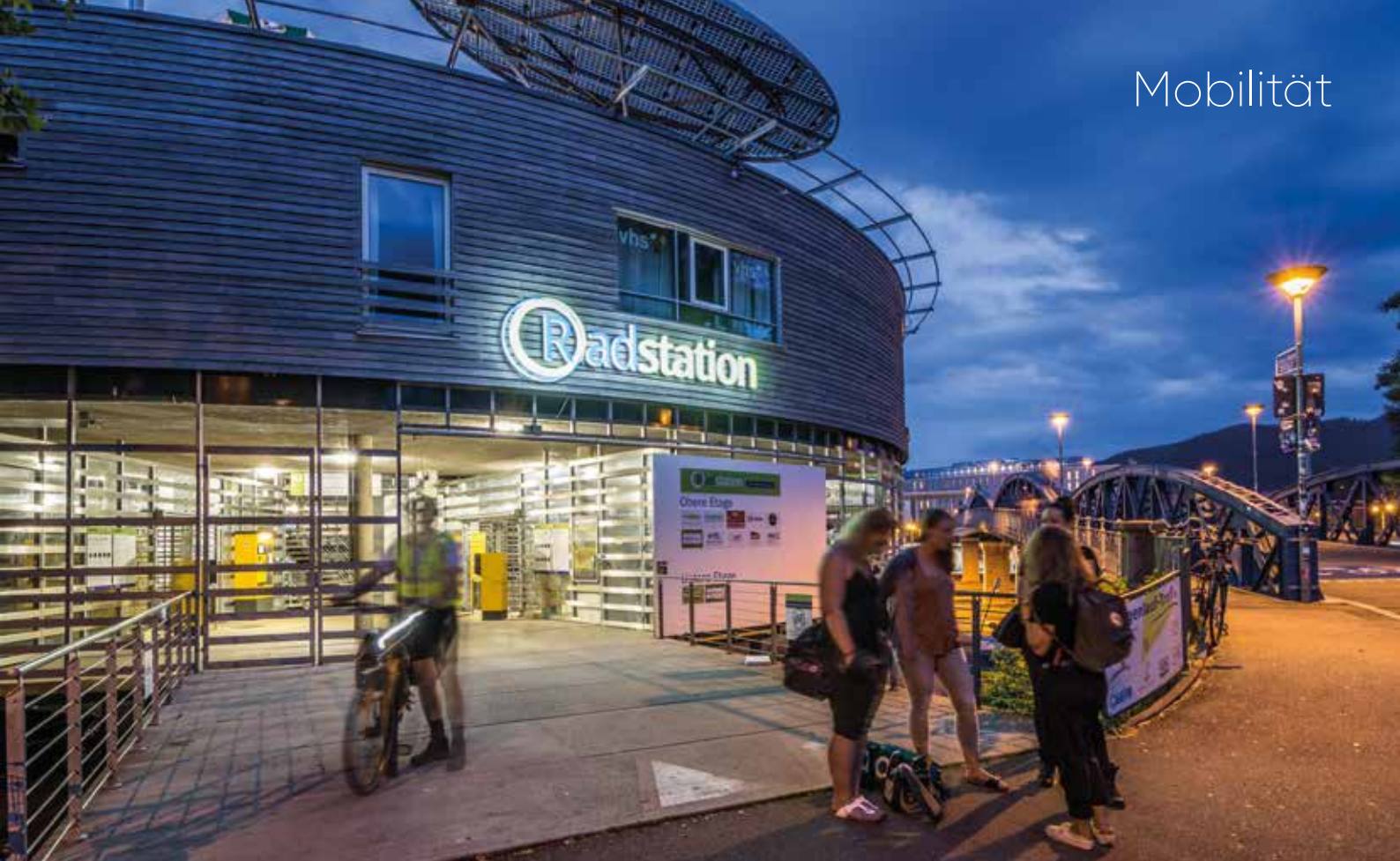
Die Radstation am Freiburger Hauptbahnhof mit Platz für rund 1.000 Fahrräder.
