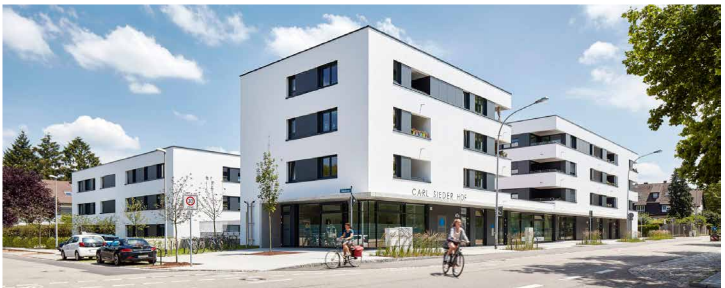
Service-Wohnungen mit Tages- und Nachtpflegeeinrichtung Uni-Carré, Freiburg
