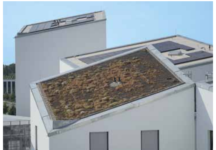
Extensiv begrünte Pulldächer verbessern das Mikroklima
