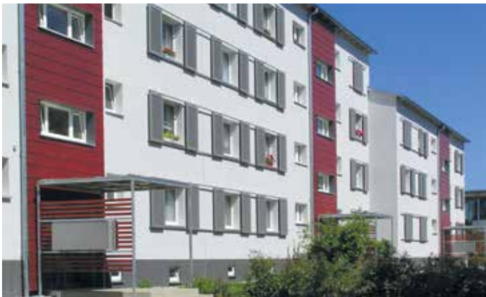
Sanierte Gebäude in Käppelerstraße
